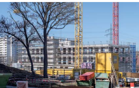
Stuttgart-Rot: Baustelle Rotweg
