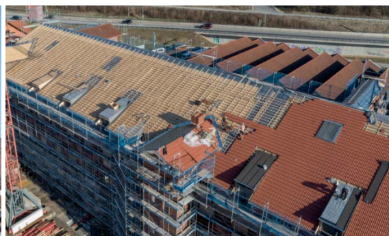
Wendlingen: Bauarbeiten an der Neckarspinnerei
